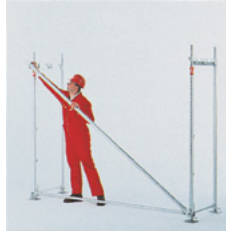
Monteer diagonaal en vloer
