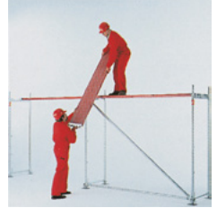
Monteer vloeren 1 o niveau
